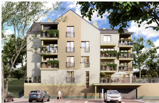
Widok na budynek
